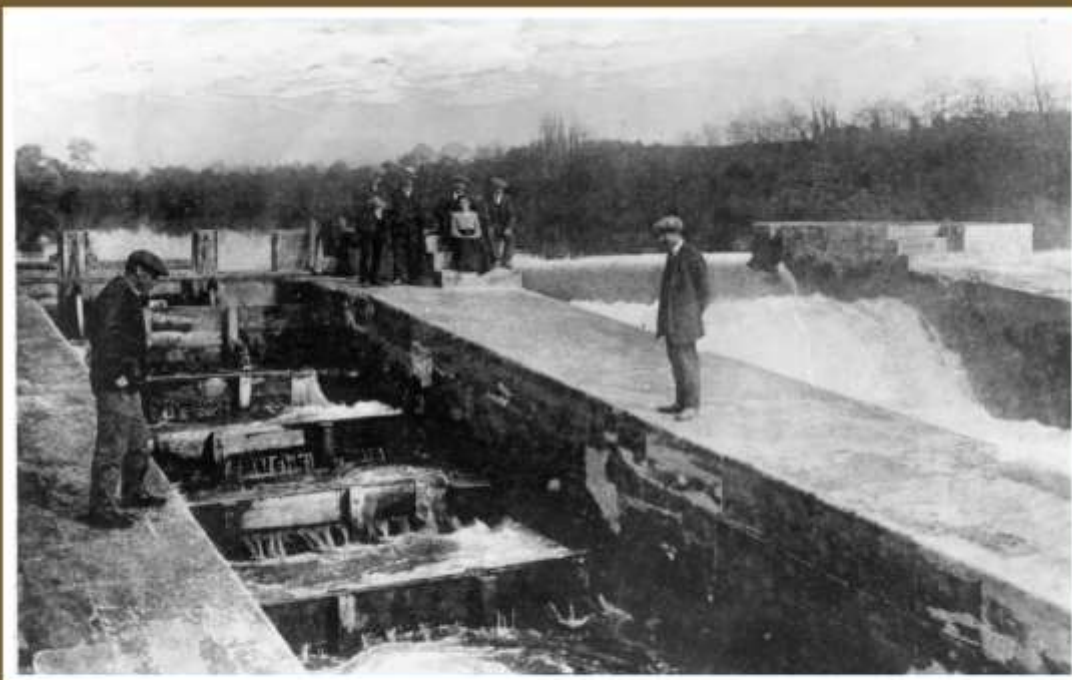
Echelle à poisson du barrage de Salvette (1851) Bergerac
