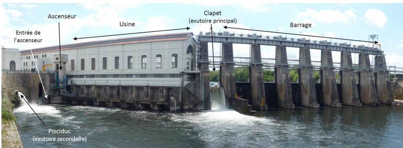
Fig. 10 : Vue aval du barrage de Tuilières. Sur cette photo, on constate l'importance du débit déversé par le clapet de dévalaison qui pourrait constituer un éventuel attrait pour les poissons en montaison. A gauche de l'ascenseur (en rive droite), on aperçoit le débouché du « pisciduc ».
